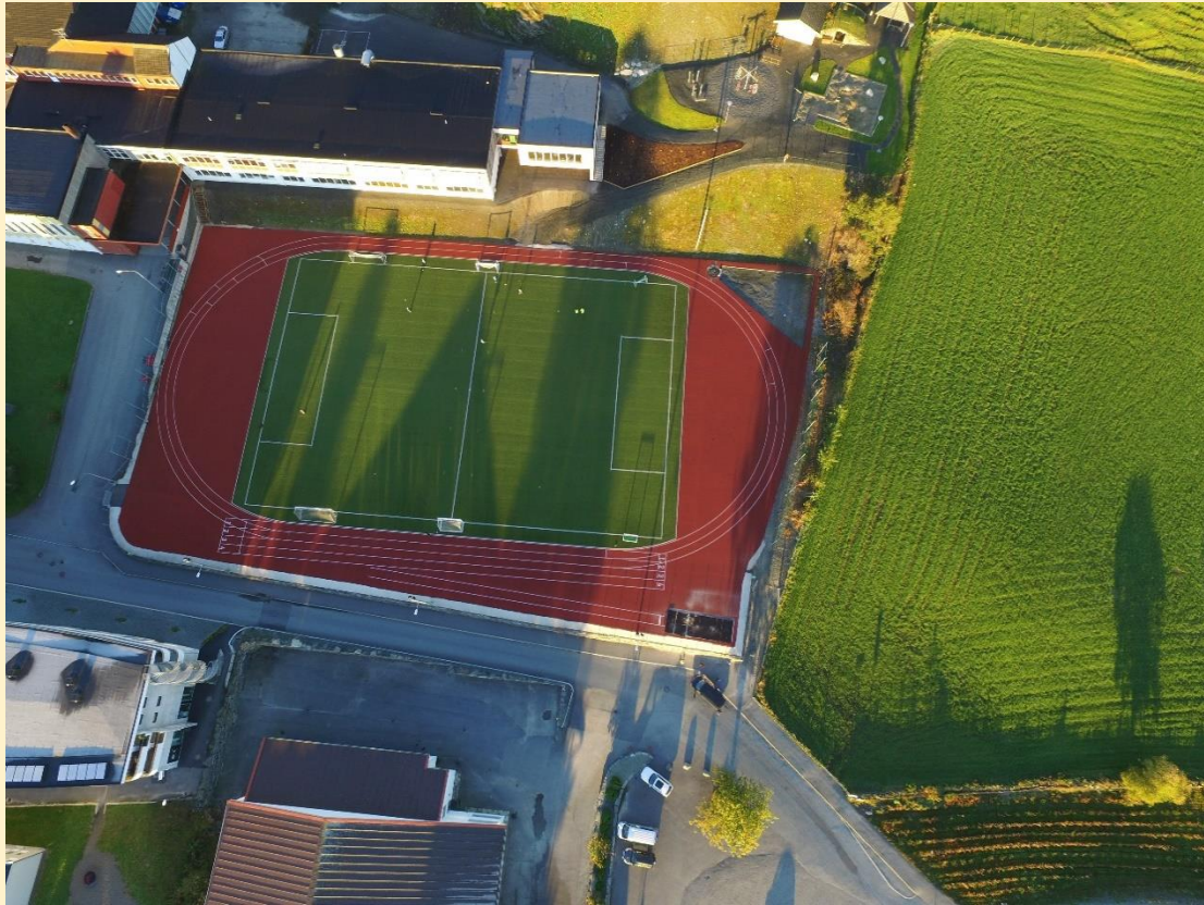
Oversiktsbilde av Finnøy sentralskole med idrettsanlegget, ferdig i 2012. Foto: Erlend Halsne
