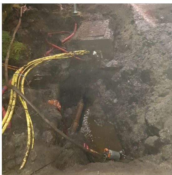
Figur 29: grøvtarbeid ifm. vannbrudd i Livegen
