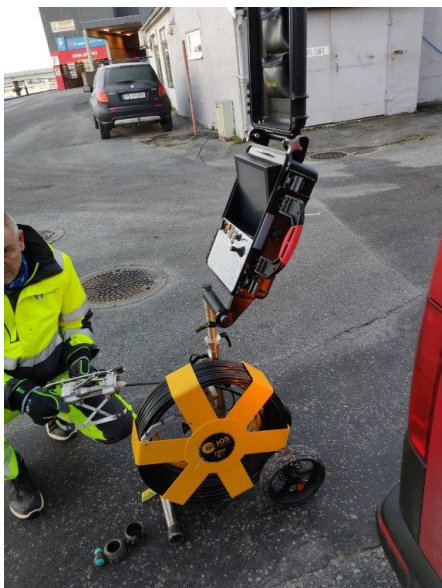
Figur 36: Inspeksjon med kamera til å finne innlekk av regnvann i avløpsnett i Mandal
