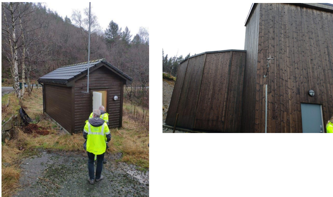
Figur 25 befaring høydebasseng i kommunen
