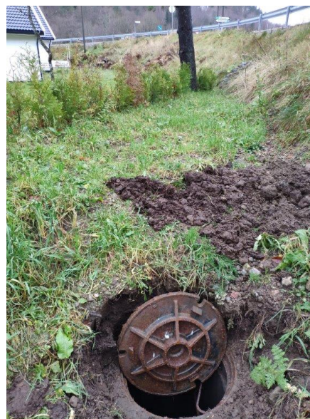
Figur 35: Framgraving av en avløpskum E39 - Sølvberget i Vigeland
