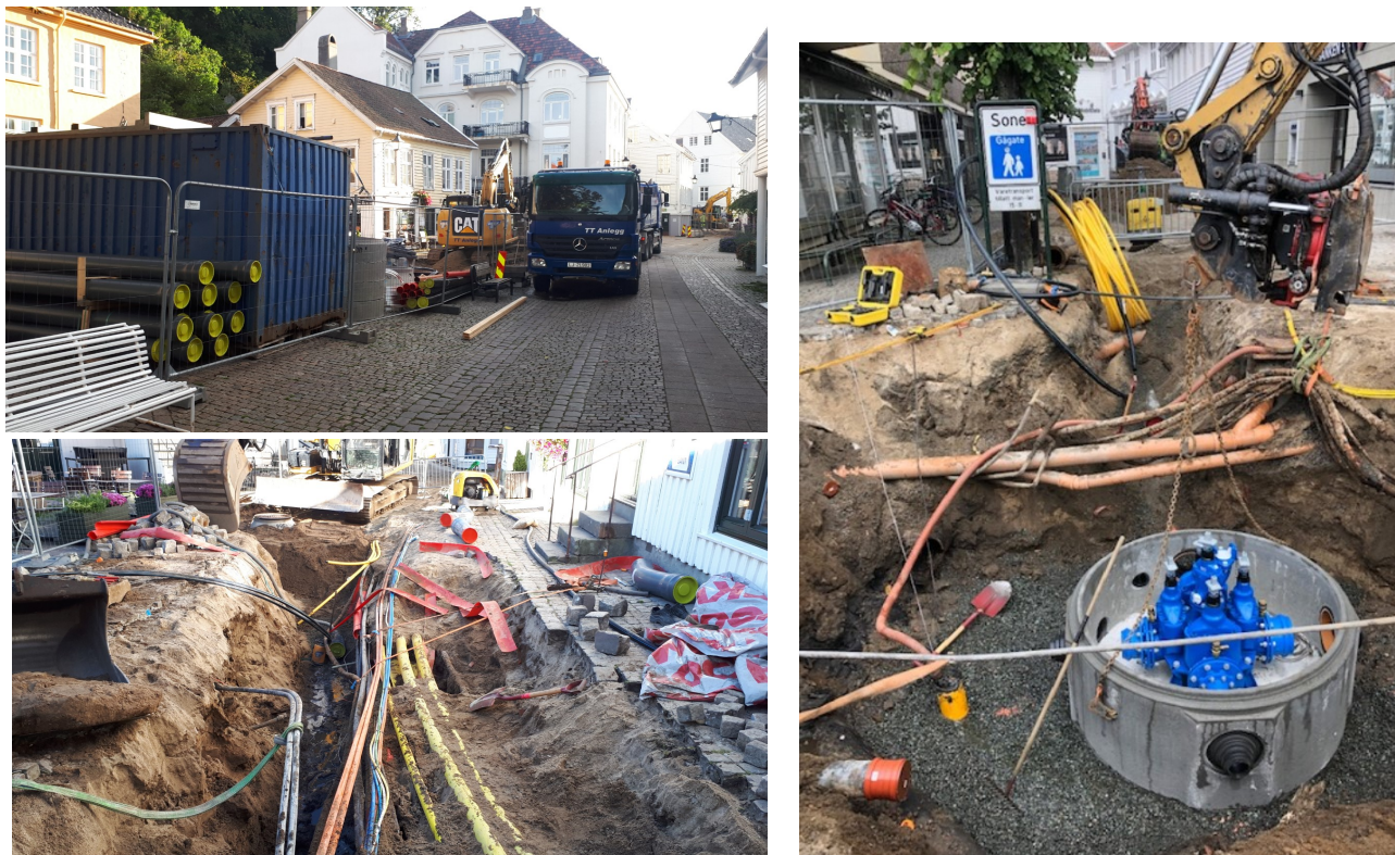
Figur 24: utskiftning av gamle jernrør i sentrum i Mandal
