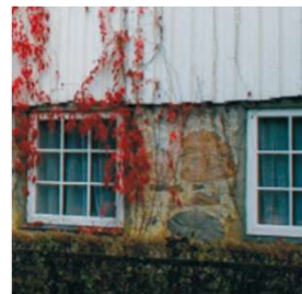
Frilagt stein i mørtel. Ytre Sandgate 24a
