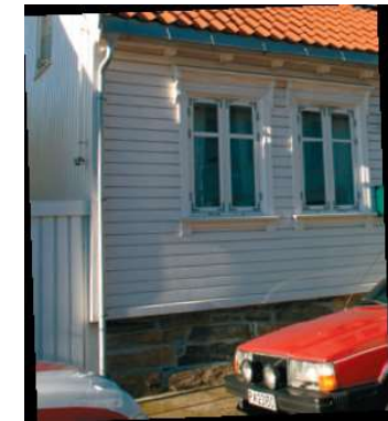
Ny, lakkert stålrinne m/rennekroker og nedløp. Mellomgata 8
