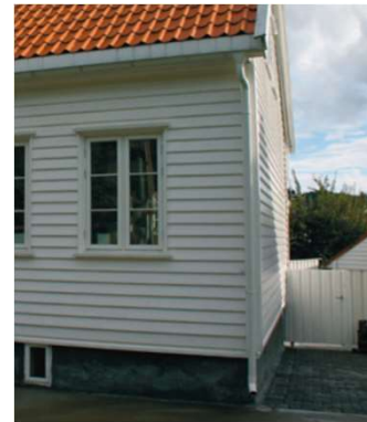
Ny, hvitlakkert stålrinne og nedløp. Kirkemurgata 1
