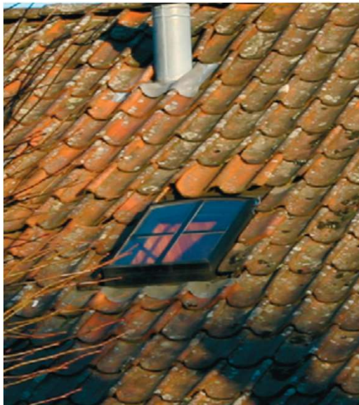
Nytt takvindu, type tilpasset verneverdige bygg.
