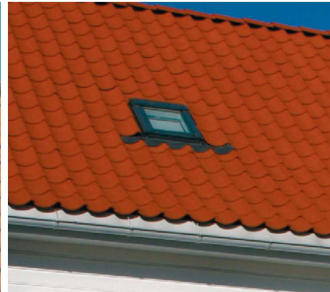
Tidligere takluke erstattet med ordinært lite takvindu. Store Elvegata 1b
