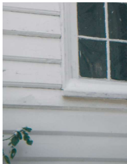
Gammel kledning øverst. Utskiftet ny kledning nederst. Store Elvegata 25
