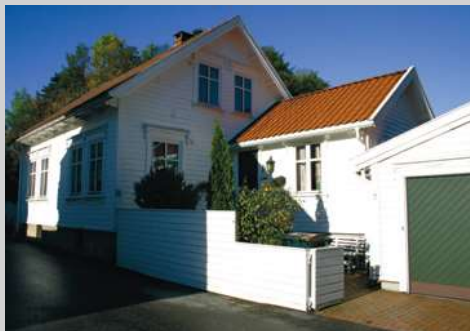
Giert Giertsens gate 13. Mindre tilbygg i forlengelse av huset, med samme hovedform
