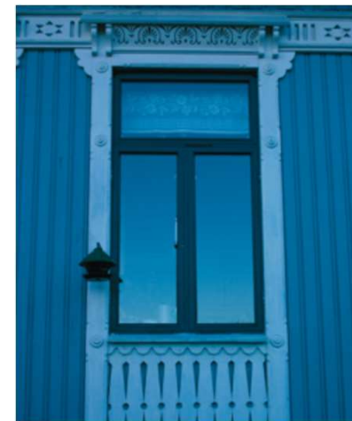
Nytt vindu innsatt med nytt og gammelt listverk.
