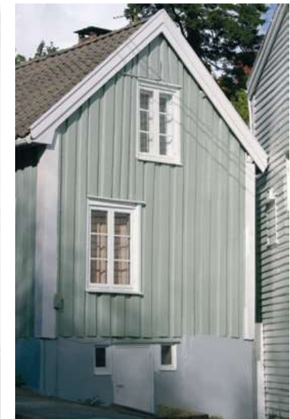
Tømmermannskledning Amaldus Nielsens gate 13
