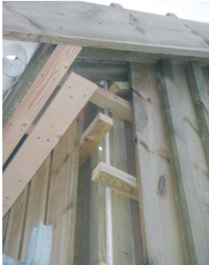
Eksempel på utførelse av knapp takavslutning. Ytre Sandgate 19
