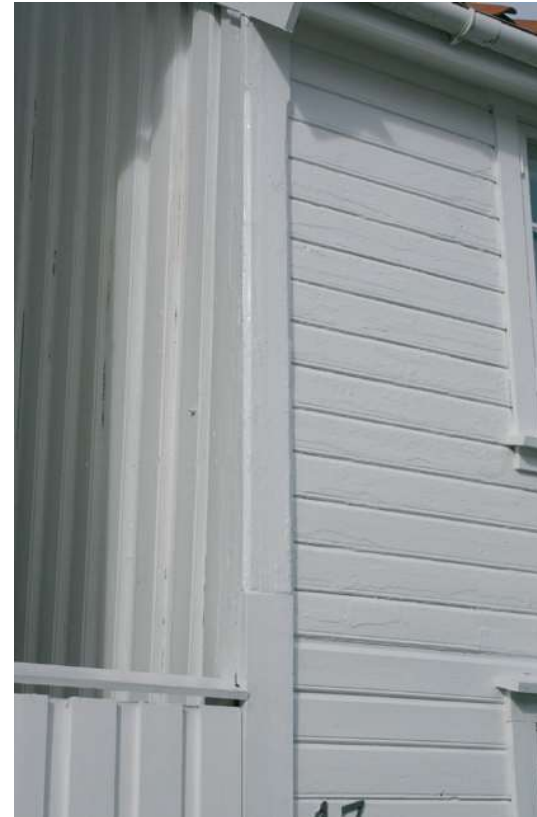
Opprinnlig kledning på gavl. Ytre Sandgate 17
