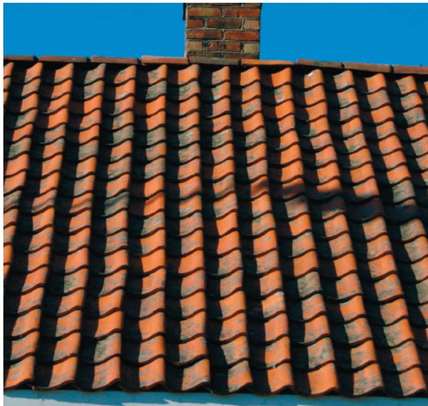
Tak tekket med gammel vingeteglstein.
