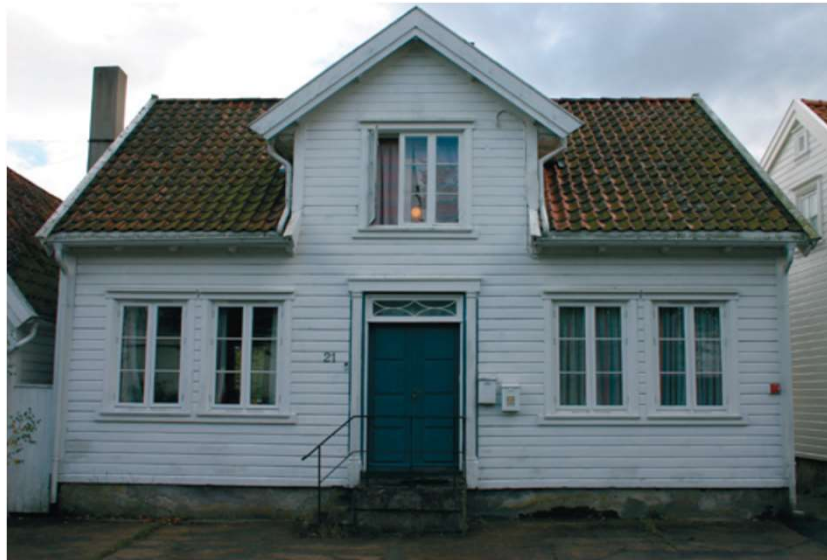
Dobbelfalset kledning. Ytre Sandgate 21
