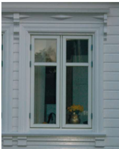
Nytt vindu med "falsk" krysspost. Johnstons gate 24
