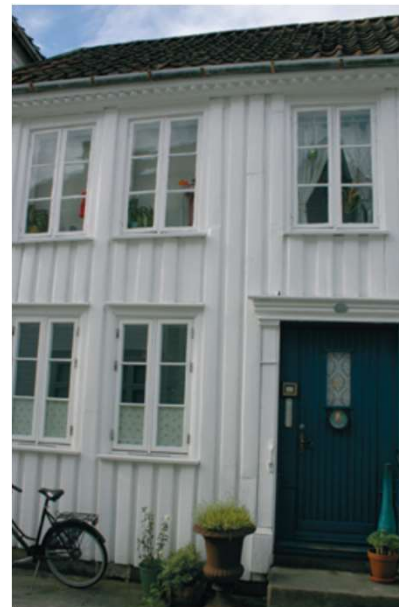
Tømmermannskledning Store Elvegata 67
