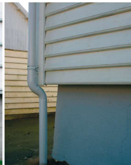
Eksempel på for stor utlekting
