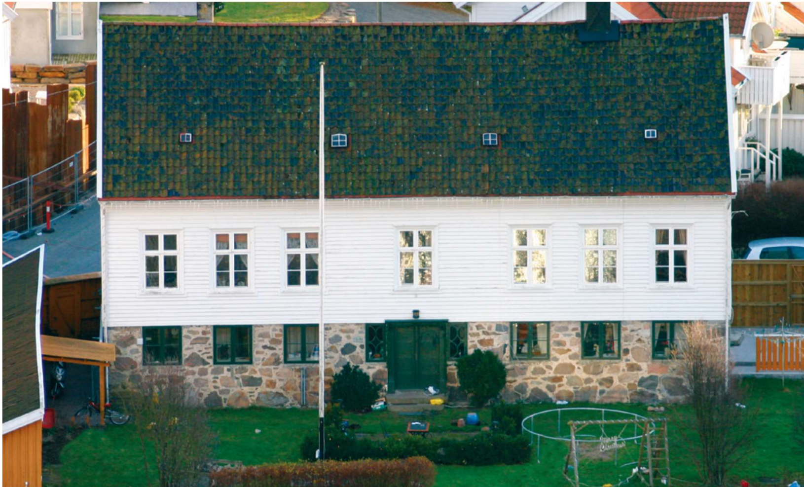
Opprinnelige støpejernsluker. Jens Dedekams vei 1
