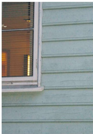
Ny enkeltfaset kledning. Store Elvegata 50
