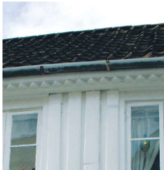
Detalj ved overgang til gesims. Store Elvegata 67
