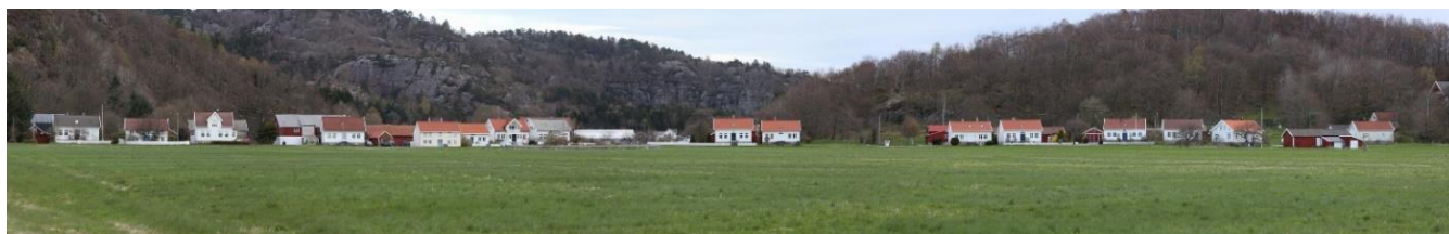
Rekketunet på Gare – representerer et karakteristisk preg når det gjelder lokal byggeskikk.
